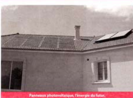
Panneaux photovoltaïques, l'énergie du futur.
